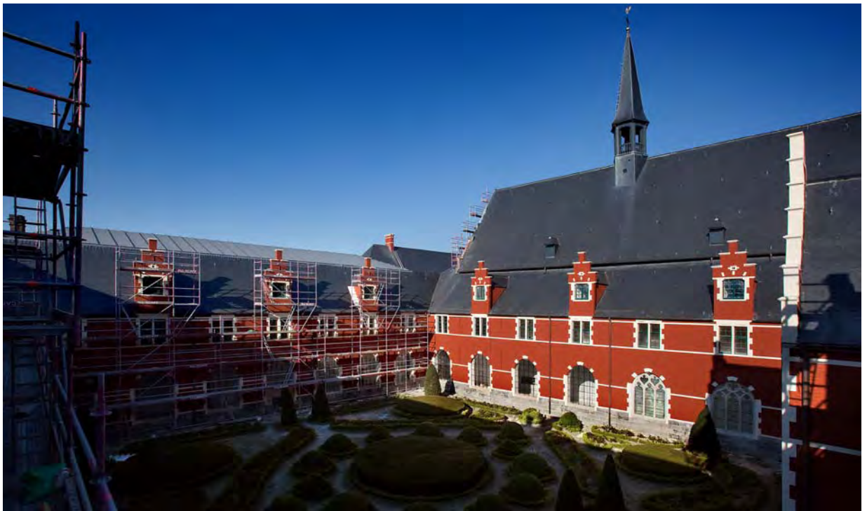
Die Bijloke-Abtei aus dem 14. Jh.: Fassadenrenovierung, April 2010 © Phile Deprez
